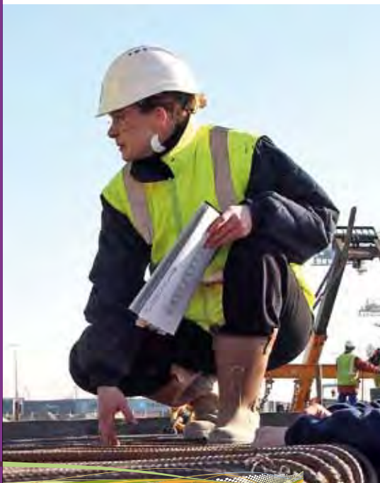
Agnès, 35 ans, chef de chantier
